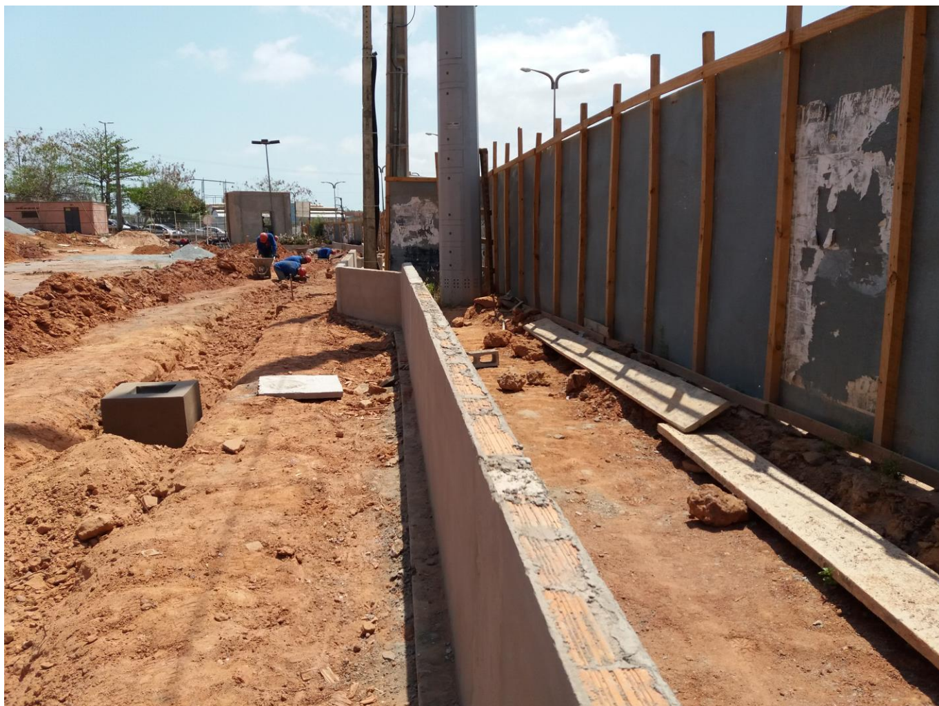
CONFECÇÃO DE MURETA PARA GRADIL FRONTAL
