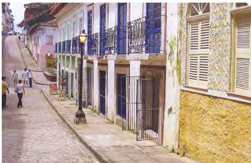
Obras de arte e fachada do Memorial do MPMA em sua primeira localização (inaugurado em dezembro de 2004)
