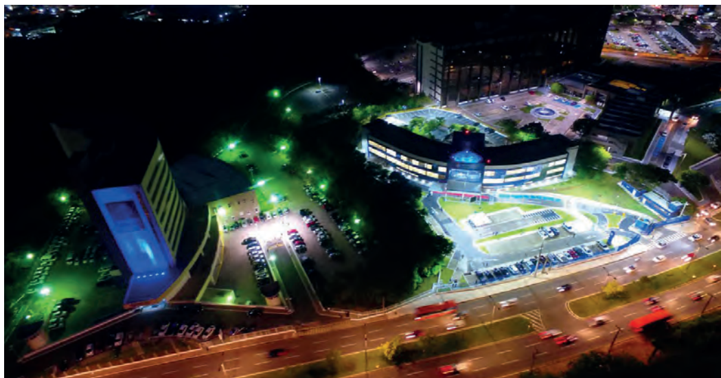
Vista aérea noturna dos prédios da PGJ e das Promotorias da Capital e arredores, no bairro Calhau
